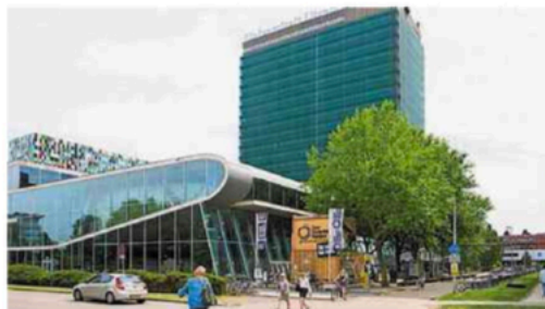
In het Van Unnikgebouw zouden studentenwoningen moeten komen, waar studenten zelf hun energie moeten opwekken.
